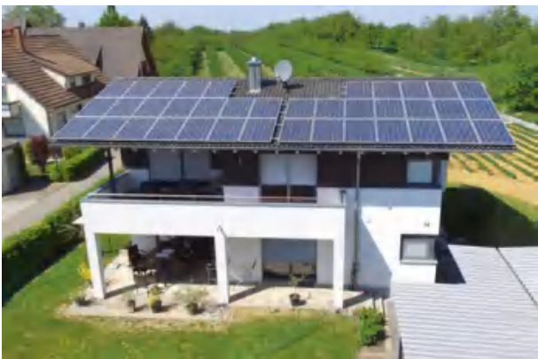
Einfamilienhaus, 10kWp, Haslach, 2016
