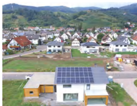
Einfamilienhaus, 8kWp, Lautenbach, 08/2020
