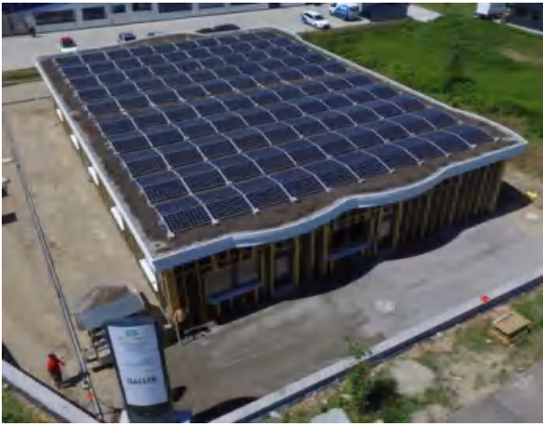
Immobilien Detlef Knöller Teningen, 63kW auf begrüntem Flachdach, 2019
