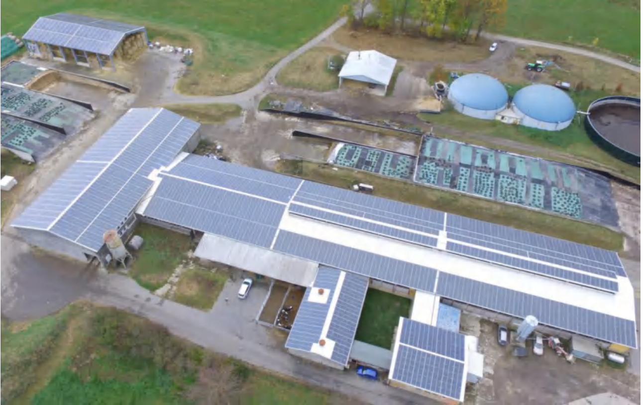
Agrargenossenschaft Burgberg Standort Burkersdorf 780kW in 10/18
