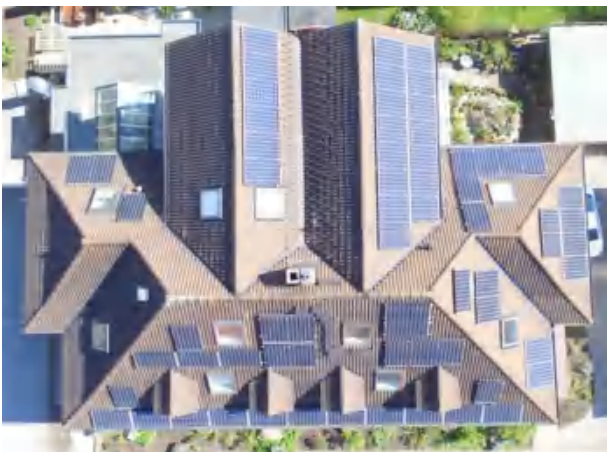
Mehrfamilienhaus, 17kWp, Kehl 12/2019
