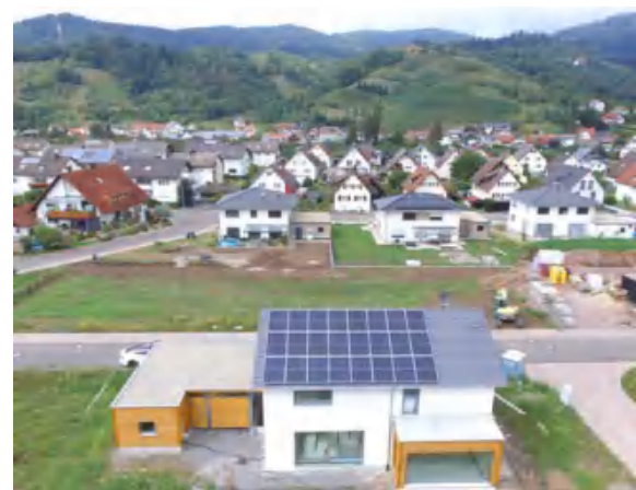
Einfamilienhaus, 8kWp, Lautenbach, 08/2020
